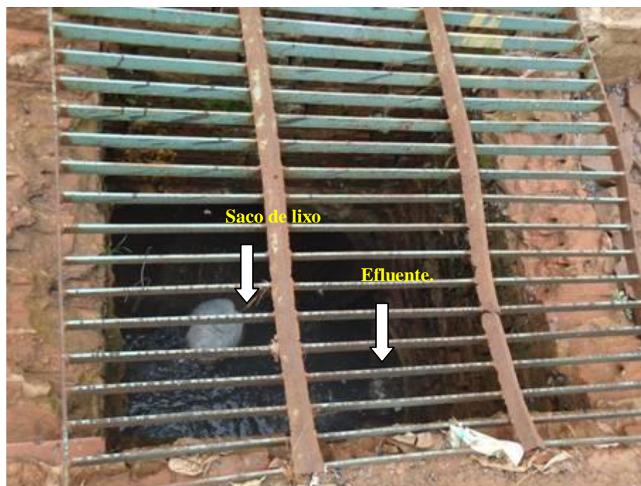
Figura 87: Boca de lobo 2 existente na rua Cabo Rocha.
