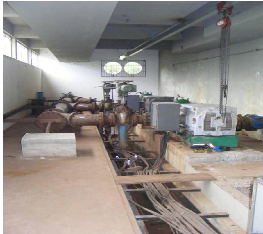
Figura 19: Motor de 500 cv da unidade de recalque.
