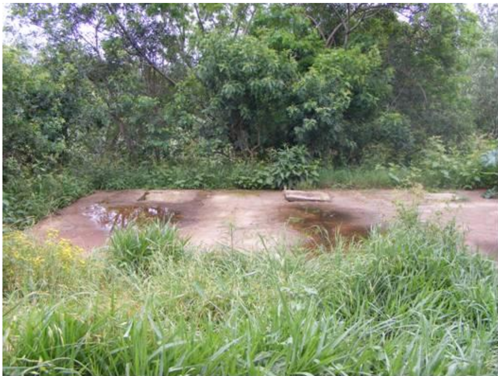
Figura 51: Extravasamento do material retido no sistema.
