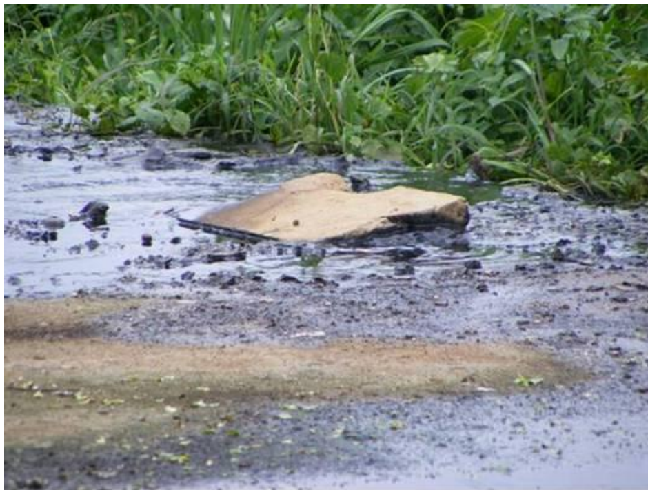
Figura 42: Extravasamento da massa líquida proveniente dos filtros anaeróbios.
