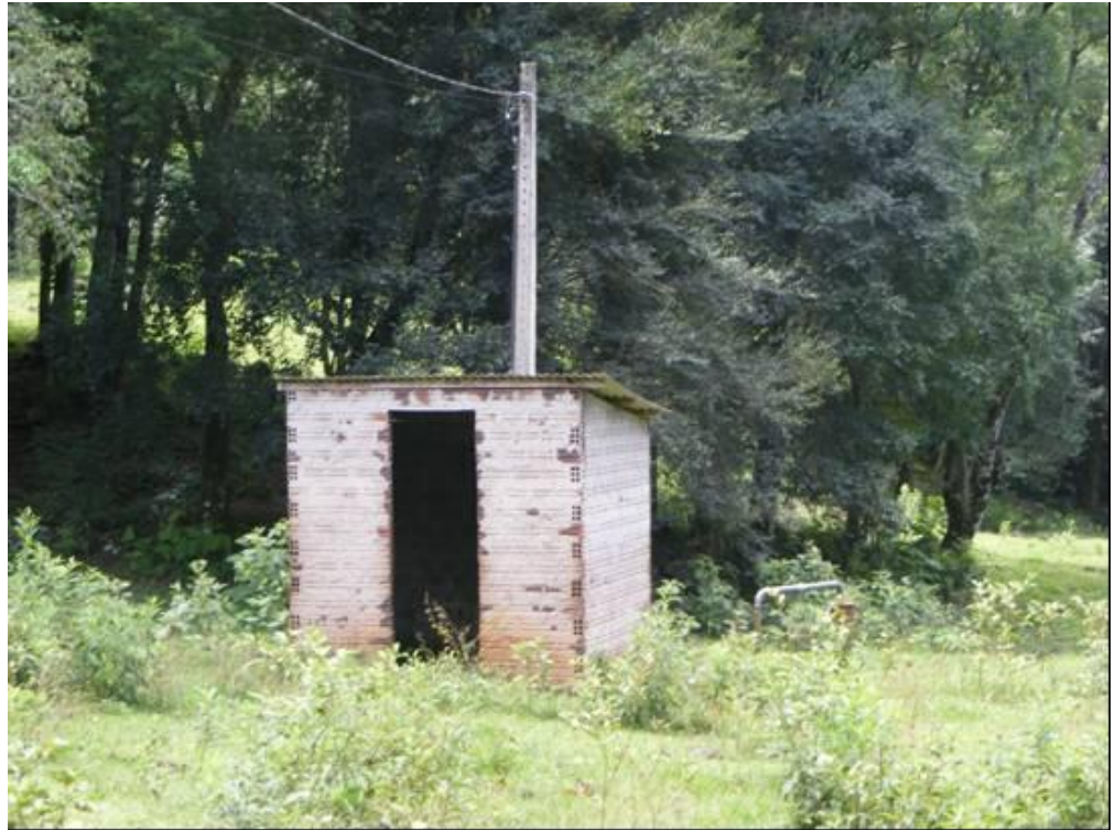
Figura 29: Poço artesiano de São Bras.
