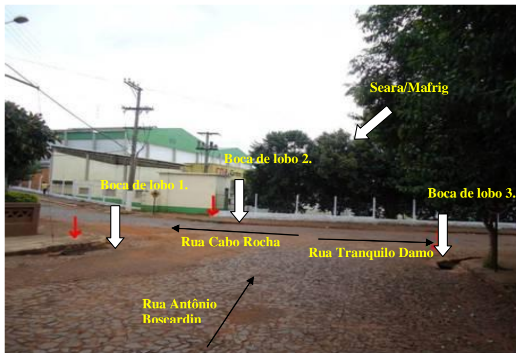
Figura 86: Bocas de lobo existentes nas ruas Cabo Rocha e Antônio Boscardin, no bairro Santo Antônio, em data posterior ao evento de alagamento.
