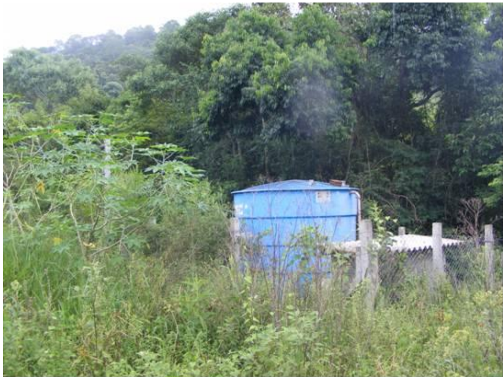
Figura 30: Poço artesiano de Alto da Colina.
