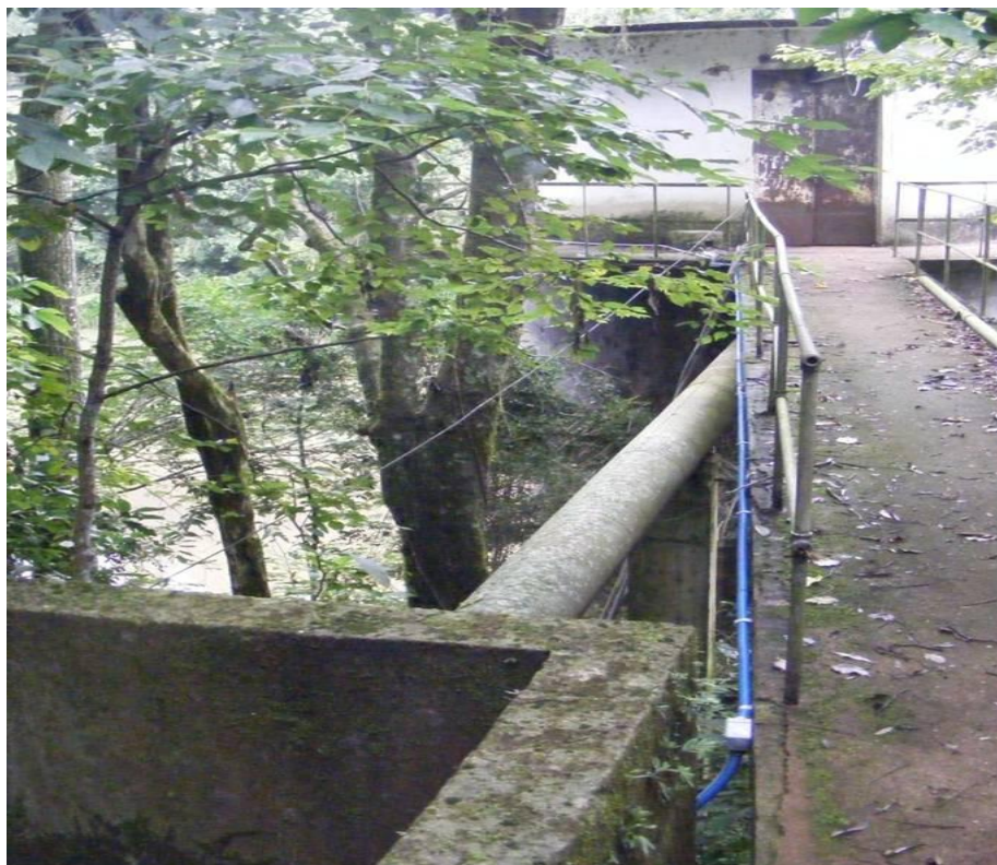
Figura 16: Torre de tomada.
