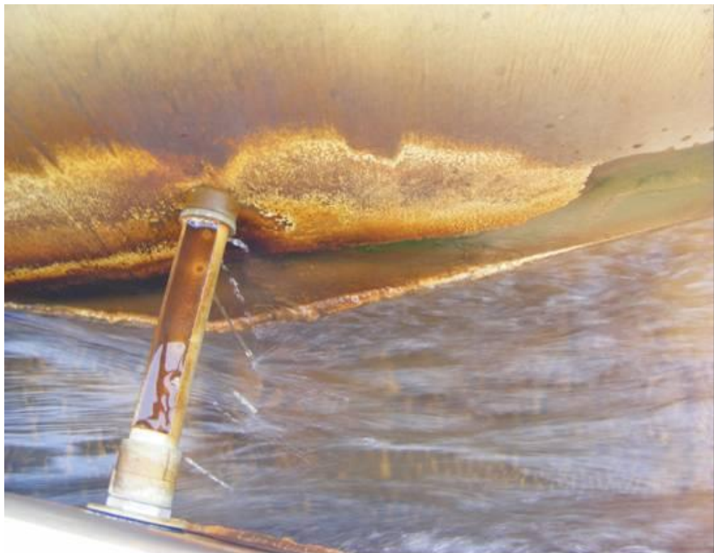
Figura 24: Adição de sulfato de alumínio líquido na água através da mistura rápida.
