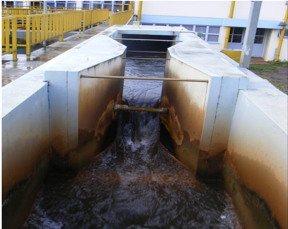
Figura 23: Detalhe da calha de água bruta.
