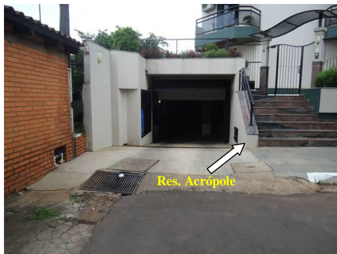
Figura 93: Boca de lobo existente na Rua Guerino Cerutti no centro em frente ao Residencial Acrópole.
